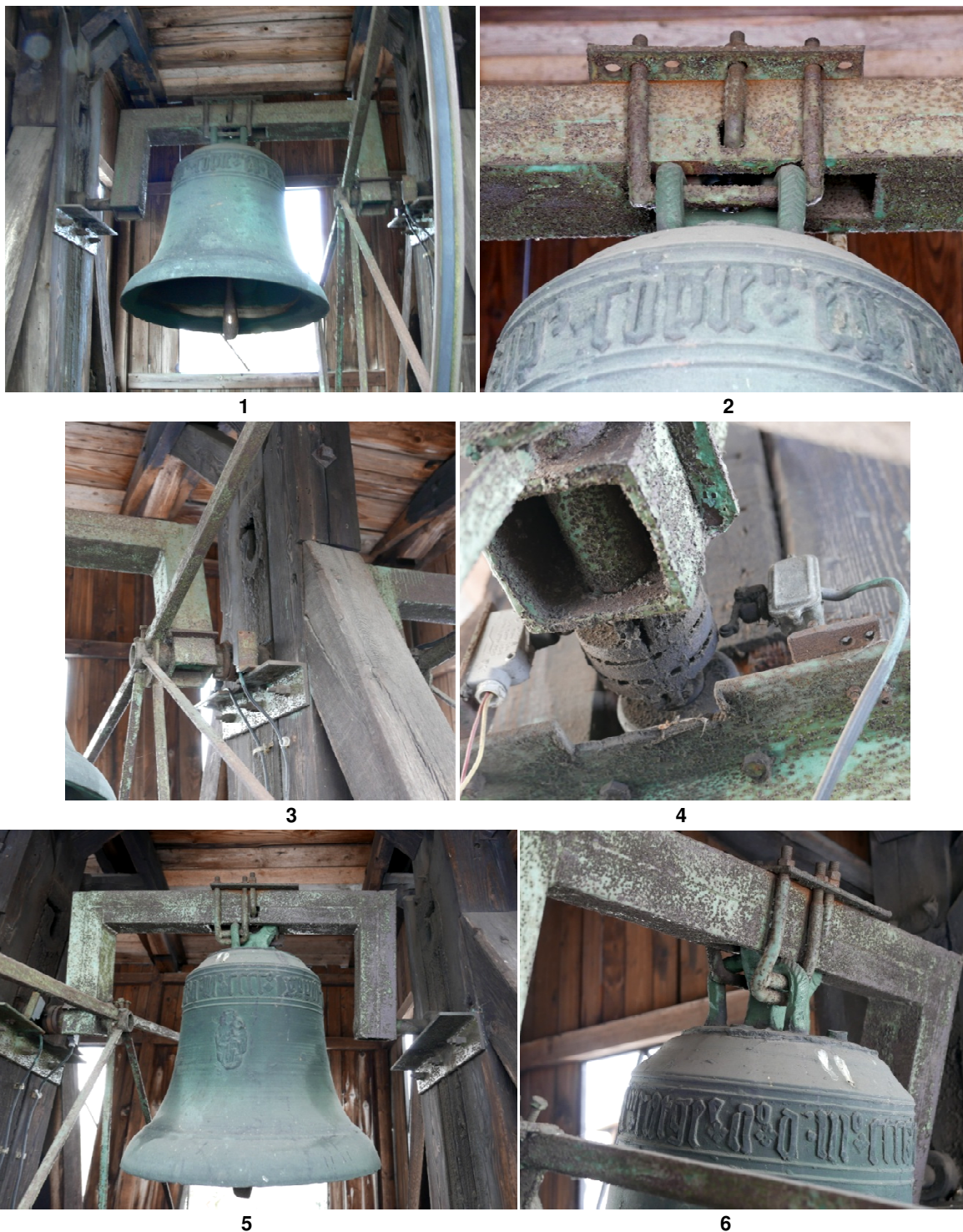
Fot. 1-5. Dwie strony dzwonu dużego (1487). Widoczny system wsporczy i zawiesie, relief Madonny z Dzieciątkiem (fot.5) wraz z plamami wody po obu stronach płaszczu dzwonu (po opadach deszczu), jako skutek nieszczelności dachu dzwonnicy.
